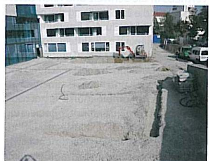
Das Unternehmen stellt derzeit die Außenanlagen der Seniorenresidenz Augustinum auf dem Stuttgarter Killesberg fertig. Hier: Bauarbeiten
